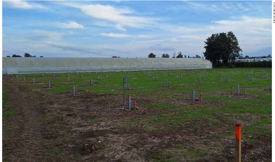
Le chantier de construction des nouveaux équipements photovoltaïques a démarré !
